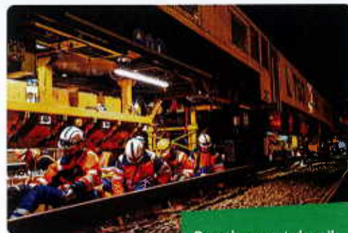
Remplacement de rails
